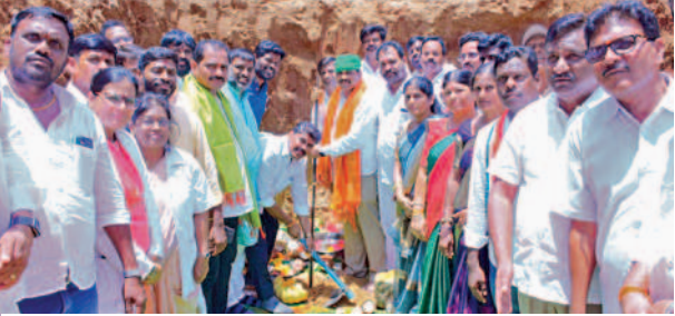
50వదకల ఆసుపత్రి భవన నిర్మాణ పనుల పూజలు చేస్తున్న కసిరెడ్డి నారాయణరెడ్డి
